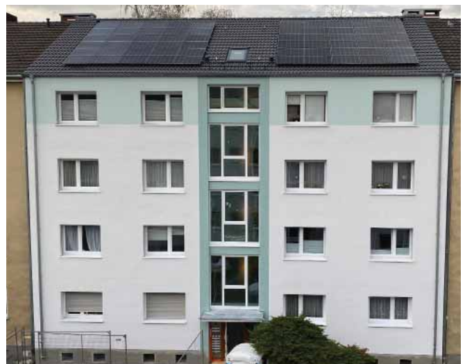
Energetische Sanierung Isselburgerstraße 6: frische Fassade und Photovoltaik auf dem Dach (li. vorher, re. nachher)
